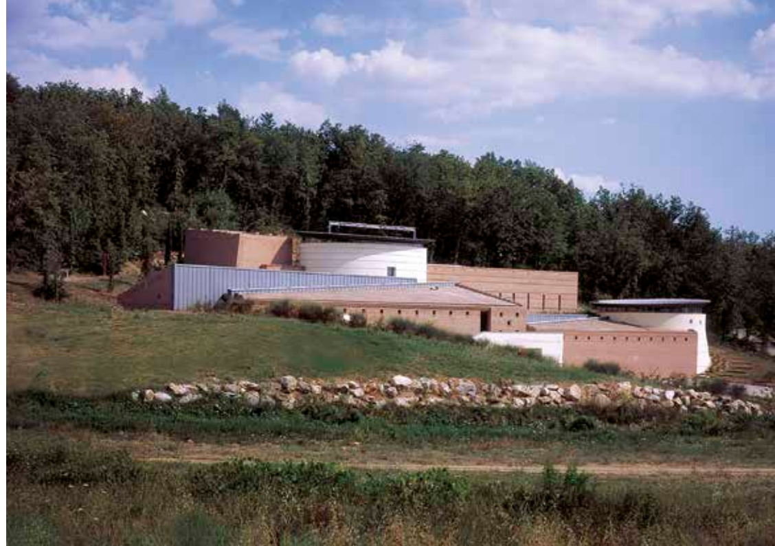
Cantina Badia a Coltibuono
